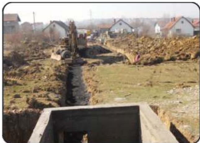
U toku je izgradnja šahtova i polaganje kablova za infrastrukturu: kanalizacija, oborinske vode, elektroinstalacije, ptt instalacije, vodu i toplifikaciju.
